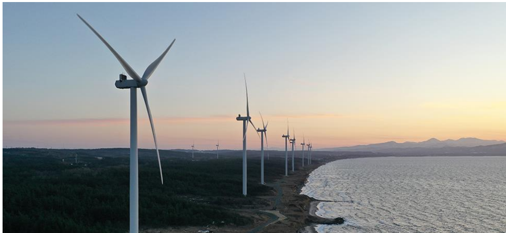
図-4 野辺地陸奥湾風力発電所
