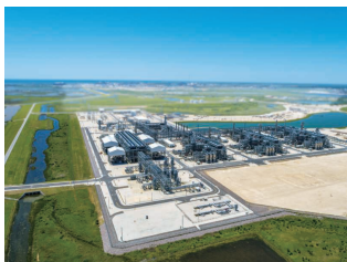
フリーポートLNG基地 (米国テキサス州) (写真提供: Freeport LNG Development.L.P.)
