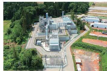
株式会社INPEXと実証運転を行っているメタネーション試験設備の外観（新潟県） （写真提供：株式会社INPEX）
