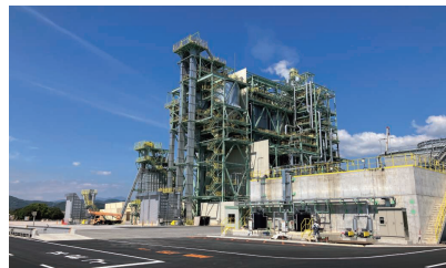
日向バイオマス発電所（宮城県）
