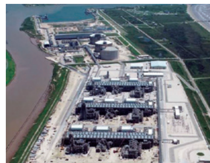
フリーポートLNG基地(米国テキサス州) (提供:Freeport LNG Development, L.P.)
