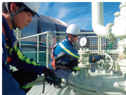
ガス供給設備(ガスホルダー)の点検作業の様子
