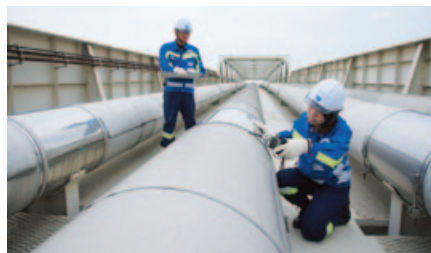
橋梁管の安全点検
