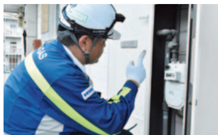
復旧作業(メーターガス栓の開栓)の様子
