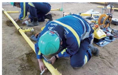
ガス管の修繕訓練
