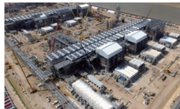
フリーポートLNG基地（建設中） (提供：Freeport LNG Development, L.P.)
