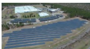
米国SolAmerica Energy, LLCが過去に開発・建設した太陽光発電所 SolAmerica Energy, LLC提供
