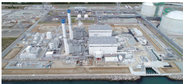
福島天然ガス発電所
