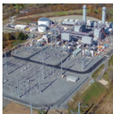
米国フェアビュー 天然ガス火力発電所
