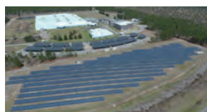
米国SolAmerica Energy, LLCが過去に開発・建設した太陽光発電所 SolAmerica Energy, LLC提供
