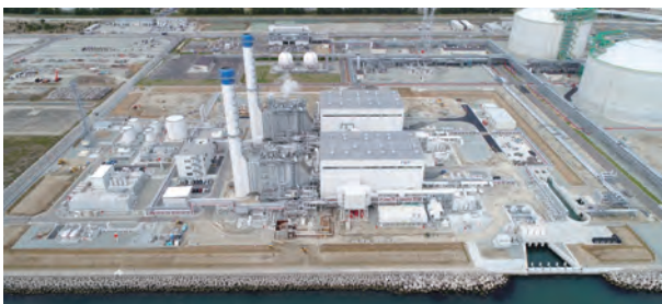
福島天然ガス発電所
