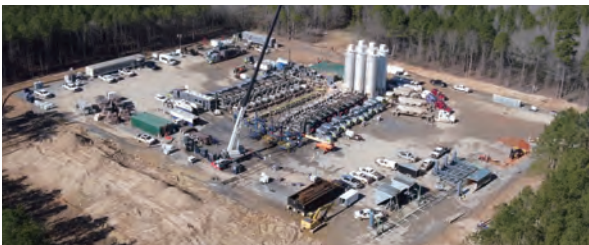
米国Sabine Oil & Gas Corporationのシェールガス鉱区
