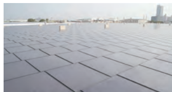
西島太陽光発電所
