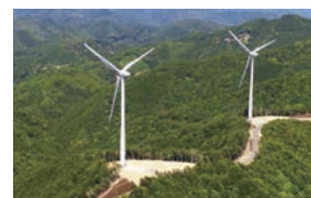
印南風力発電所
