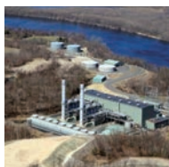
クリーンエナジー 天然ガス火力発電所
