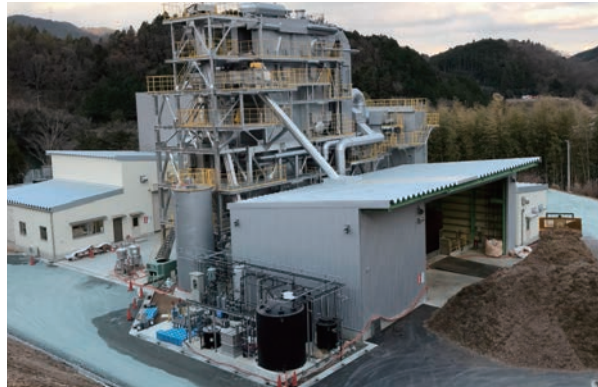
松阪バイオマス発電所
