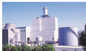
西島エネルギーセンター
