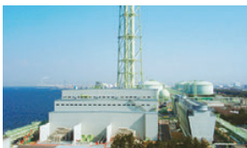
泉北天然ガス発電所
