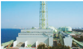
泉北天然ガス発電所
