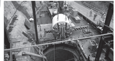
パイプライン敷設 (開削) 工事
