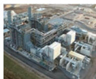
ショア発電所
