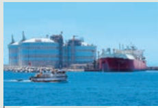
サグントLNG基地
