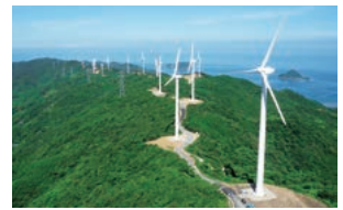
広川明神山風力発電所 (和歌山県)
