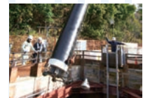
姫路・岡山ライン工事
