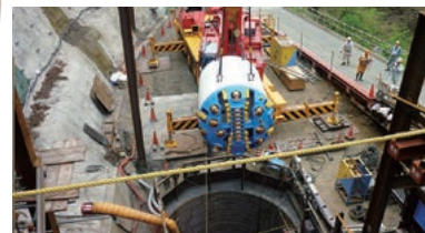
パイプライン敷設（開削）工事
