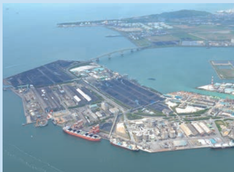
山口宇部パワー(株) 発電容量: 120万kW(予定) / 発電設備: 超々臨界圧(石炭) ボイラ / 運転開始: 2020年代前半(予定)
