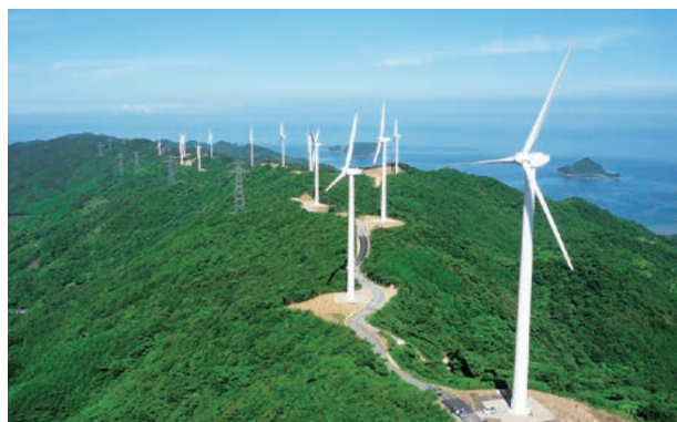
広川明神山風力発電所（和歌山県）
