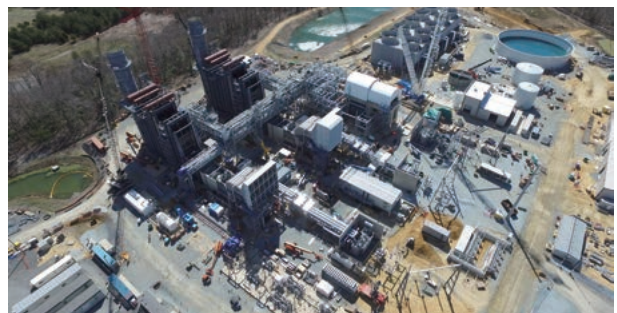
セントチャールズ天然ガス火力発電所 (建設中)
