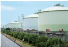
輸入したLNGをタンクに貯蔵し、海水の熱で気化させ、熱量を調整してガスを製造しています。泉北・姫路の2つの製造所でガスを製造し、都市ガスの安定供給に努めています。
