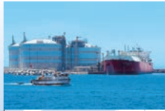
サグントLNG基地
