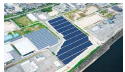
西島太陽光発電所(大阪府)
