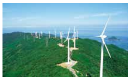
広川明神山風力発電所(和歌山県)
