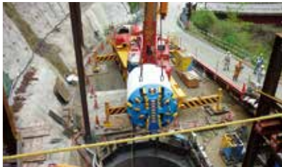
パイプライン敷設(開削)工事
