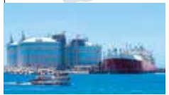
サグントLNG基地
