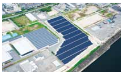
西島太陽光発電所
