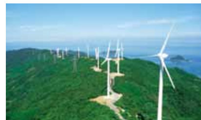
広川明神山風力発電所
