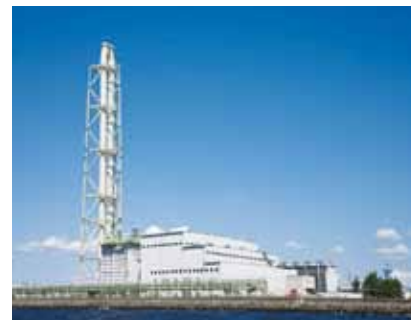
泉北天然ガス発電所
