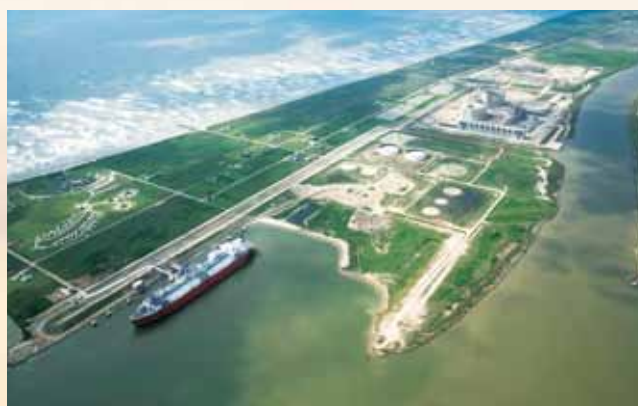
フリーポートLNG基地(アメリカテキサス州ヒューストン市) 提供: Freeport LNG Development, L.P.
