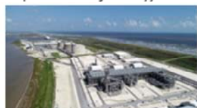
Freeport LNG Project By courtesy of Freeport LNG Development, L.P.
