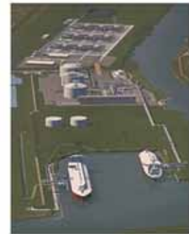
LNG exporting terminal (Completion image)
