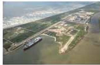
LNG receiving terminal (existing)
