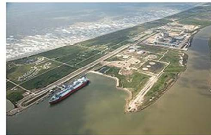
LNG receiving terminal (existing)
