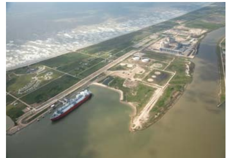
Freeport LNG terminal
