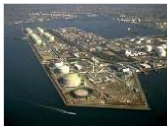
Senboku LNG Terminal II
