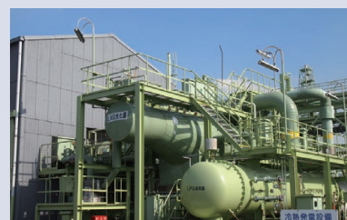
LNG cryogenic power generation facilities at the Senboku LNG Terminal
