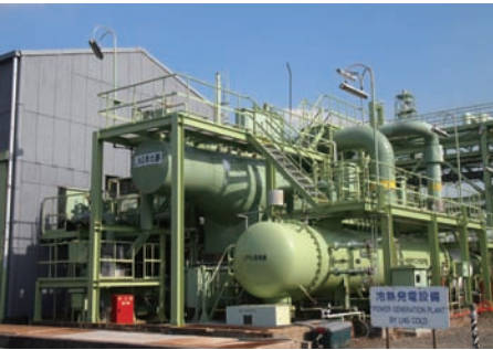
LNG cryogenic power generation facilities at Senboku LNG Terminal
