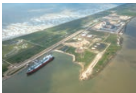
Freeport LNG Terminal (Source: Freeport LNG Development, L.P.)
