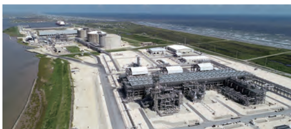
Freeport LNG Terminal in the United States Courtesy of Freeport LNG Development, L.P.
