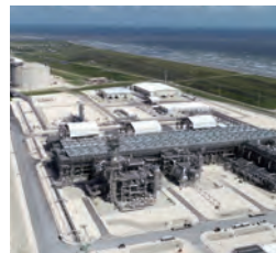
Freeport LNG Terminal in the United States Courtesy of Freeport LNG Development, L.P.
