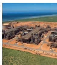
Gorgon LNG Project
