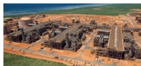
Gorgon LNG Project
