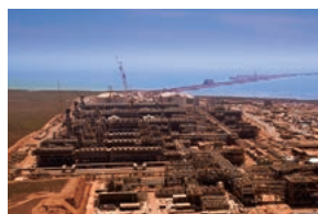
Gorgon LNG Project
