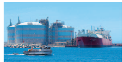
Sagunto LNG Terminal (Spain)
