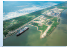
Freeport LNG Terminal Photograph courtesy of Freeport LNG Development, L.P.
