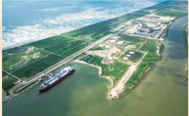
Freeport LNG terminal (Houston, Texas, U.S.A.) Photograph courtesy of Freeport LNG Development, L.P.
