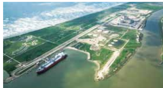
Freeport LNG terminal Photograph courtesy of Freeport LNG Development, L.P.
